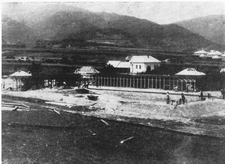
Fotografia z výstavby kúpaliska 1931–1932 pred jeho dokončením.
